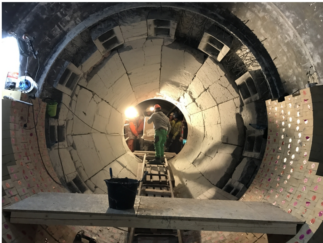
شکل ۲. کاربرد فراورده و سرامیک‌های نسوز در بدنه کوره‌های صنعتی
